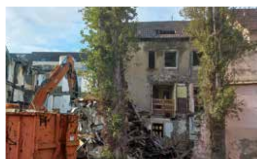
La démolition des bâtiments n°33 à 39. Une étape clé avant la création d'une nouvelle liaison piétonne et d'espaces publics plus verts, ouverts et conviviaux.
