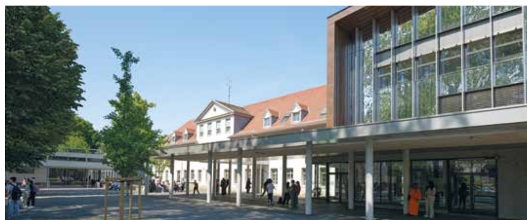
La rénovation-extension du collège Kennedy de Mulhouse, réalisée pour la Collectivité européenne d'Alsace (CeA) est un cas typique de chantier complexe en site contraint de centre-ville. Quatre bâtiments ont été réhabilités et remis aux normes d'accessibilité, sécurité et performance énergétique. Un bâtiment neuf a été créé pour accueillir le CDI, les salles de sciences et les locaux dédiés aux enseignants. Un square aménagé pour les collégiens est ouvert au public hors temps scolaire (livraison : 2023).
