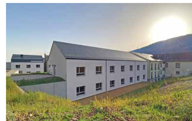
Construction d'une Unité Centralisée de Production de Repas (UCPR) et extension de deux ailes avec une Unité de Vie Protégée (UVP) ainsi que la restructuration d'une partie de l'EHPAD existant - ORBEY.
