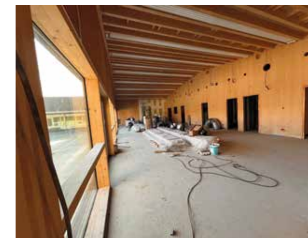
Chantier EHPAD Rouffach - Construction bois.
