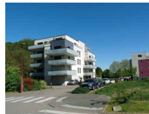
Un programme immobilier de logement construit sur une ancienne friche industrielle. Sa réalisation a nécessité l'évacuation de terres impactées par la pollution, ZAC Saint-Jacques - Thann.
