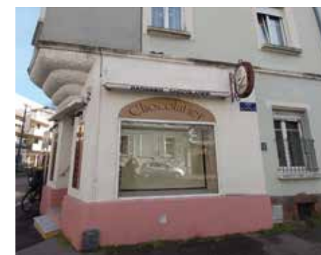
Local en cours de restauration pour accueillir un commerce de bouche.
